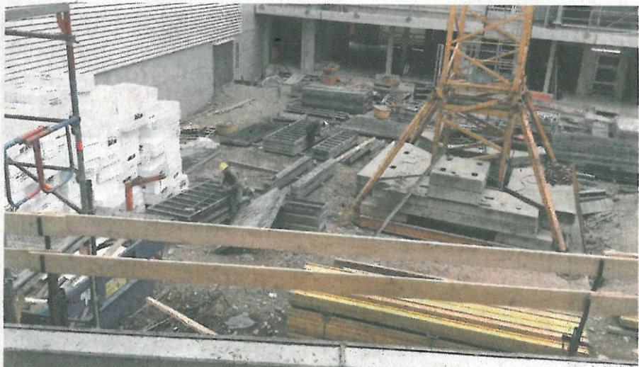
Noch eine Großbaustelle: Im Frühjahr nächsten Jahres wird das Vorhaben fertig sein.
