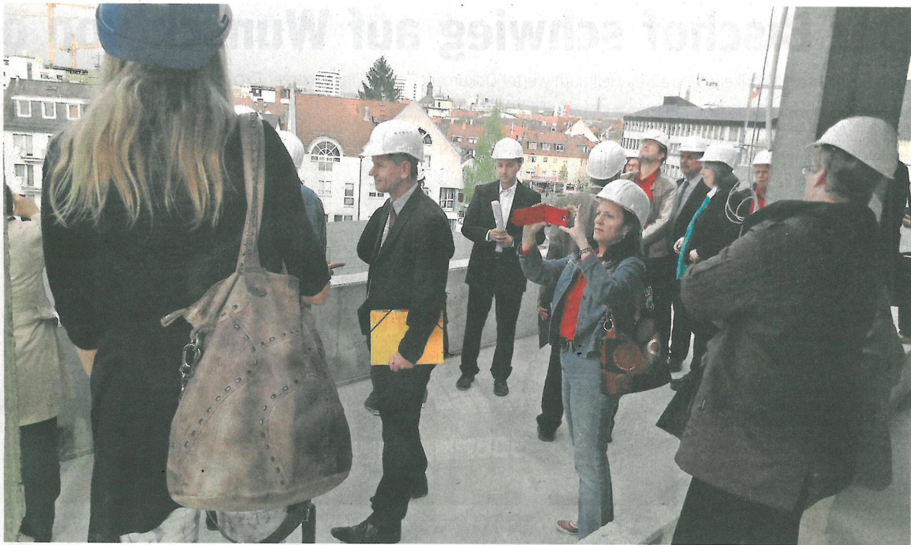
Rundblick über die Stadt Hanau: Bei einer Baustellenbesichtigung haben sich die Besucher über Größe und Vielfalt des künftigen Gloria Palais informiert.
