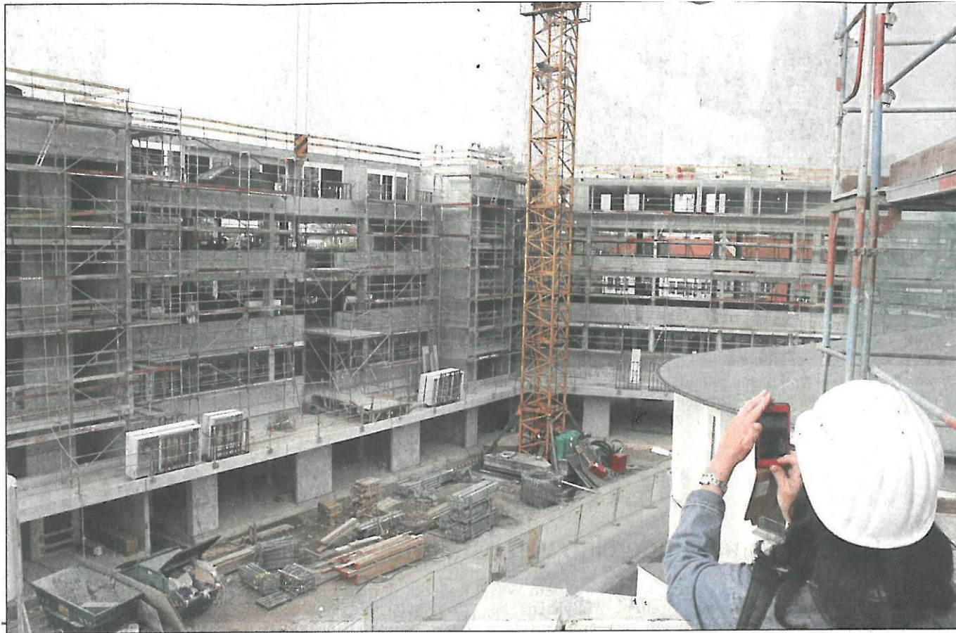
Arztpraxen, eine Apotheke, eine Software-Firma und auch ein Restaurant soll es künftig im Neubau-Komplex am Westbahnhof geben, zu dem auch ein Parkhaus mit 330 Stellplätzen gehört. Der Rohbau steht bereits und der Innenausbau läuft ■ Foto: Spindler
