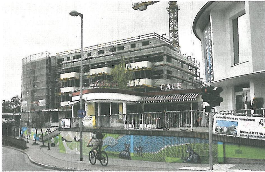
Baufortschritt: Neben denkmalgeschützten Häusern entsteht ein Neubau. Foto Dieter Rüchel
